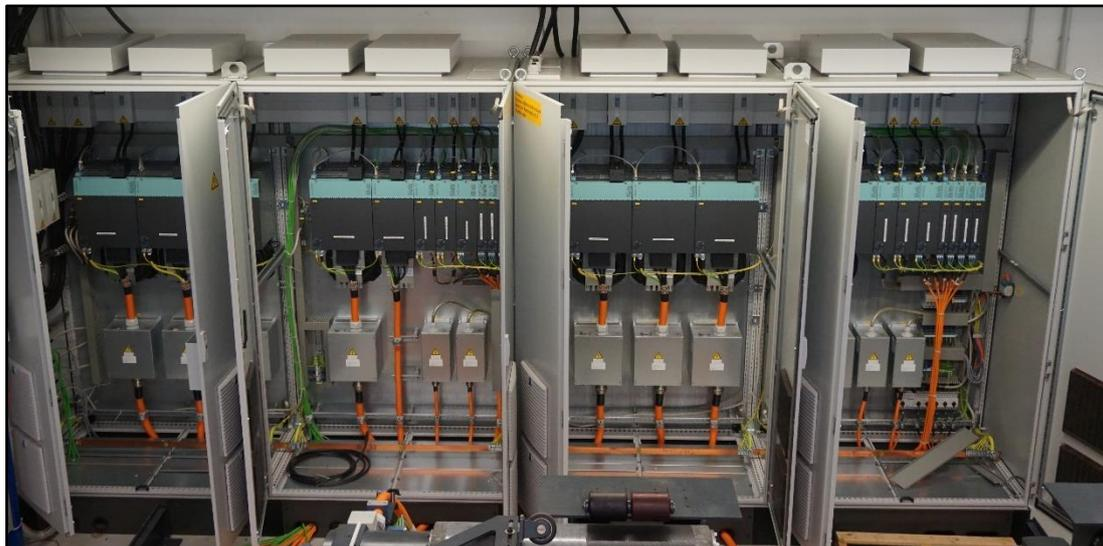
Bild 4: Innenansicht der Schaltschranke mit Umrichtern
