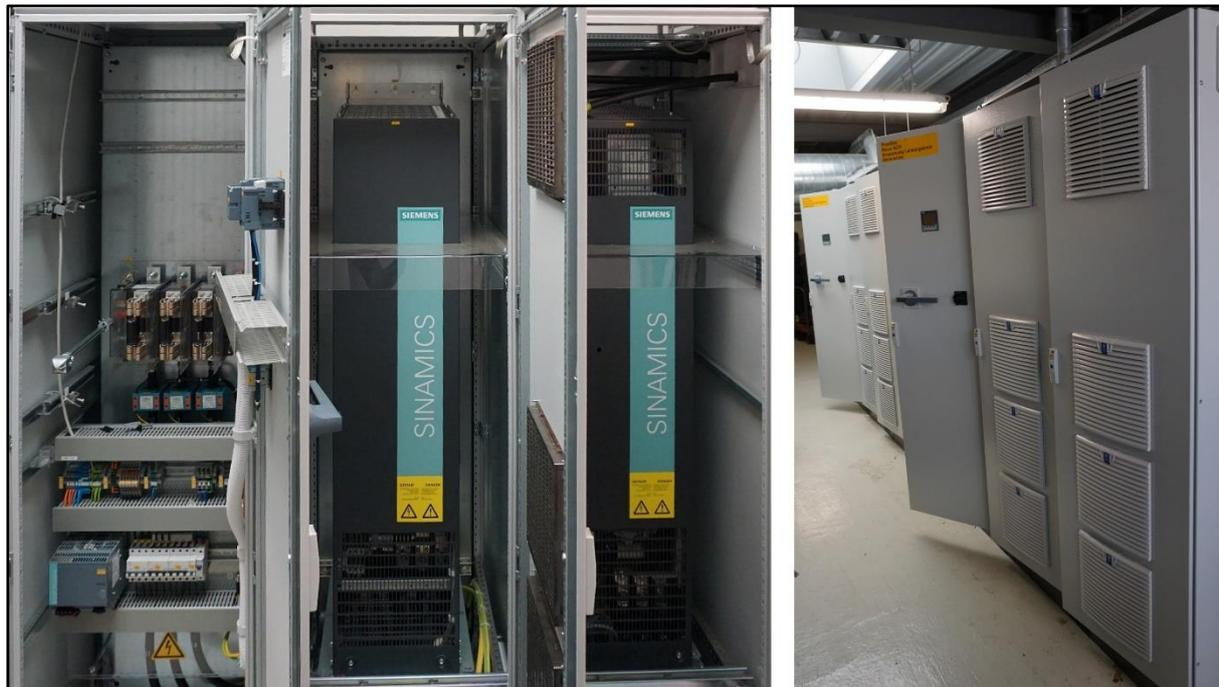
Bild 5: Innen- und Außenansicht Schaltschranke mit Gleichrichtern
