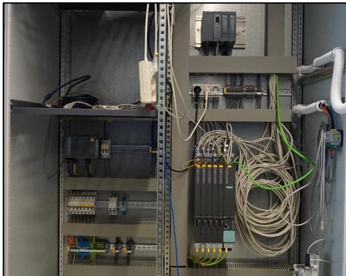
Bild 3: Innenansicht des Schaltschranks mit programmierbarer Motion-Control-Steuerung
