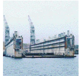
515 000 Euro wurden für dieses Schwimmdock des Marinearsenals Kiel aufgerufen. Bei solchen Anlagen zeigt sich, warum die Veveg in der Regel die Selbstabholung der ersteigerten Ware verlangt.
